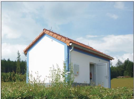
Společnost K&K TECHNOLOGY a.s. v roce 2019 vybudovala nový vodojem pro obec Hrádek u stávajícího vodojemu. Výstavba vodojemu v Hrádku nastala z důvodu nedostatečné kapacity a nevyhovujícího technického stavu. Nový vodojem má více než dvojnásobný objem 200 metrů krychlových a je zásoben vodou z prameniště a z přečerpávací nádrže. Zařízení je zásobárnou pitné vody pro cca 750 obyvatel. Obec je zásobena pitnou vodou gravitačně.
